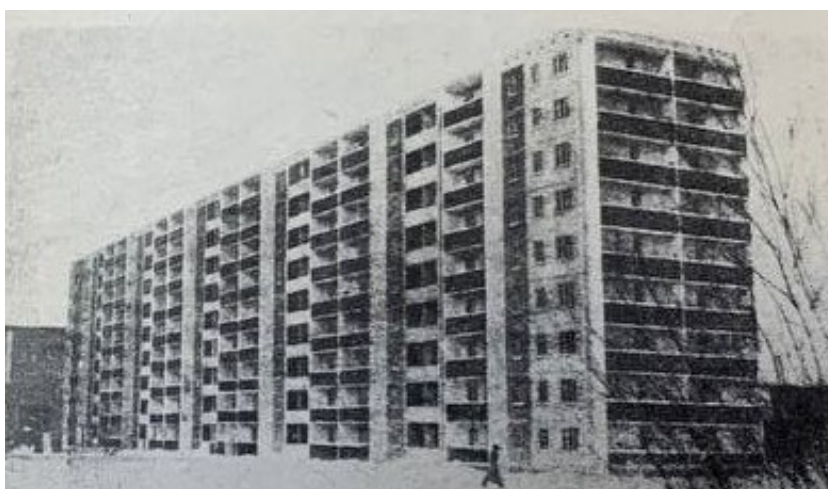
Рис. 2. Девятиэтажное здание серии III-75 с наружными стенами из шунгизитобетона [3]
